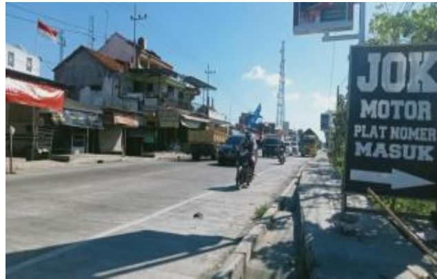
Gambar 2. Dokumentasi Jalan Raya yang sudah ditinggikan.
