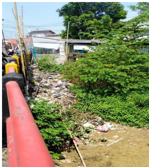
Gambar 2. Kondisi Jembatan di Desa Blega
