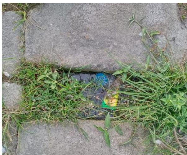
Gambar 5. Kondisi saluran pembuangan air berdasarkan pernyataan ibu Nurhayati
