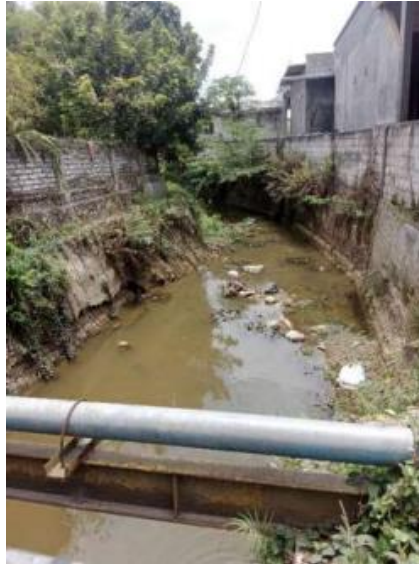
Gambar 4. Adanya bangunan-bangunan permanen disekitar sungai yang menyebabkan alur sungai tidak dapat diperlebar dan tidak dapat menambah kapasitas drainase.
