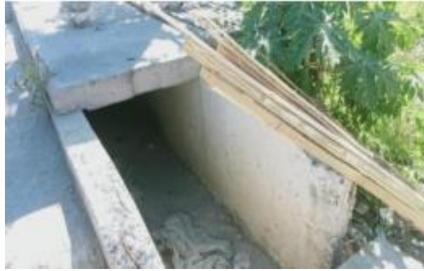
Gambar 1. Dokumentasi Selokan di Sebelah Jalan Raya.
