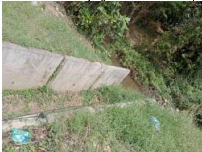
Gambar 8. Kondisi selokan menuju ke sungai yang sudah ditumbuhi rerumputan dan terdapat beberapa sampah.
