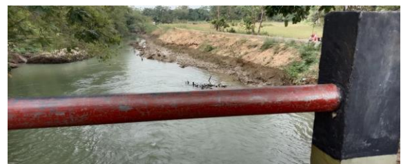
Gambar 20. Kondisi sungai setelah pengerukan dan pelebaran
