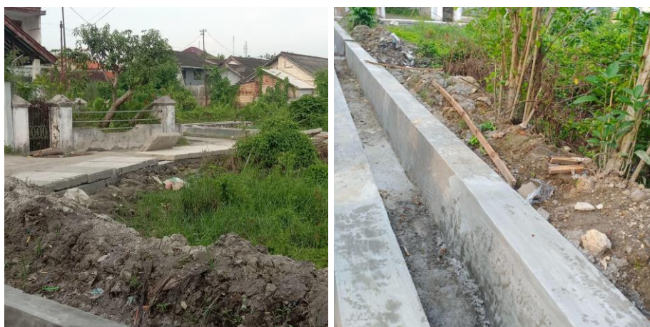
Gambar 8. Proyek rekonstruksi drainase di daerah Pesalakan
